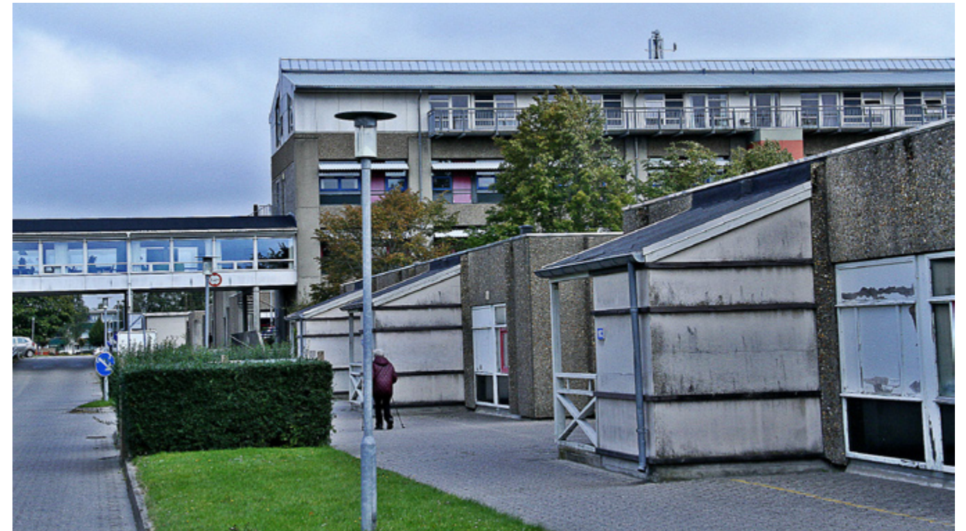
Der bliver ikke længere skiftet vinduer og døre eller udført simpelt vedligehold af boligerne på Tommerupvej.
